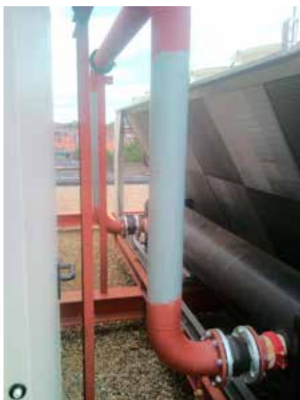
> Raccordement de groupe froid en toiture Métropole Lilloise Centre commercial
